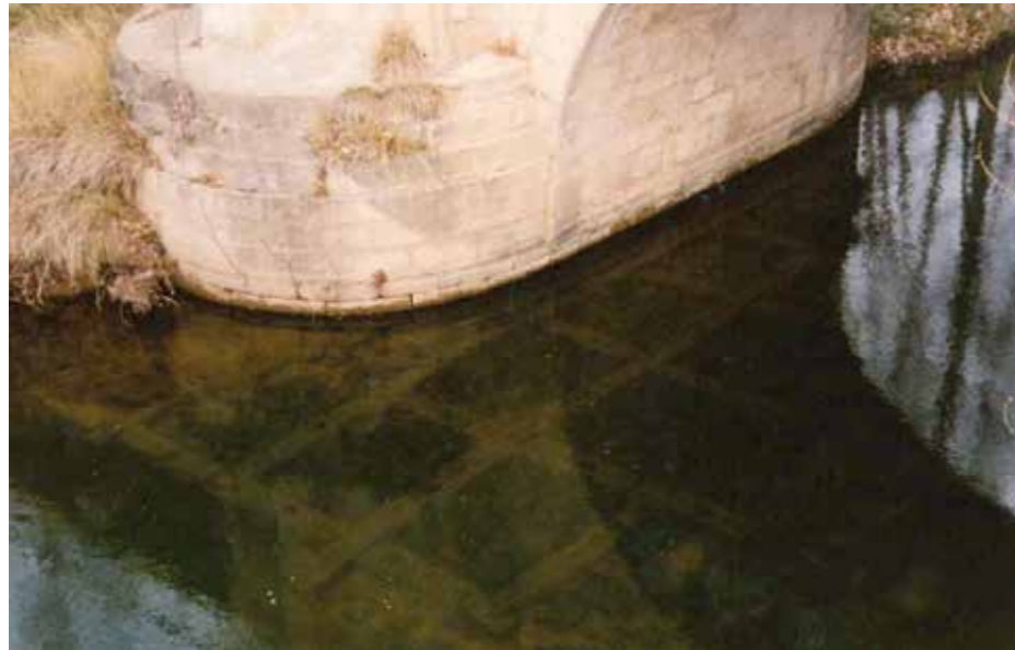
ZAMPEADO DE LA CIMENTACIÓN DE UNA PILA (DESAPARECIDO)
