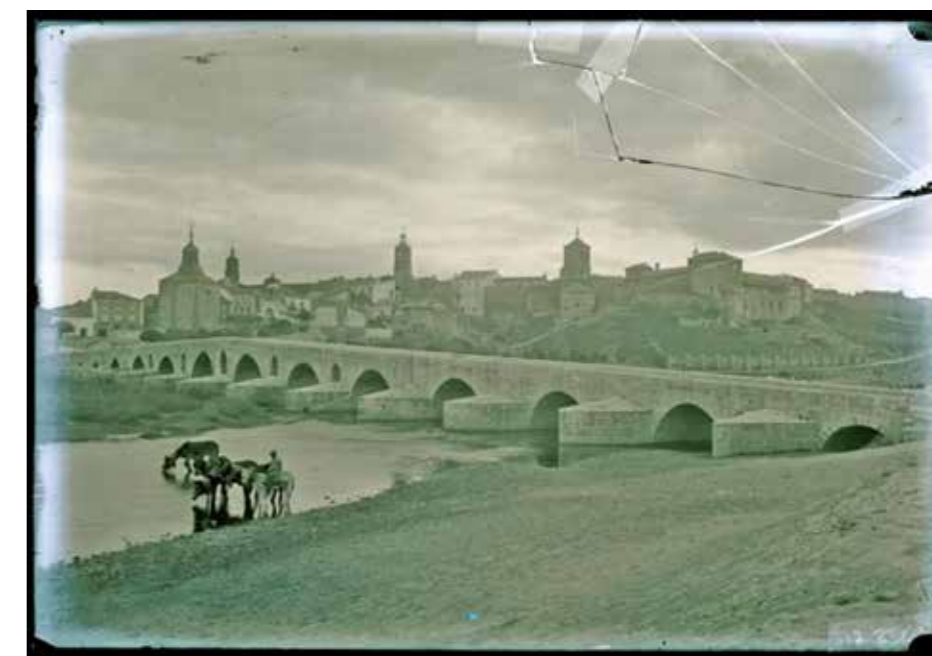
FOTOGRAFÍA DEL PUENTE ANTERIOR A 1915 CON LOS ALIVIADEROS ABIERTOS. ES LA IMAGEN QUE SE QUIERE RECUPERAR
